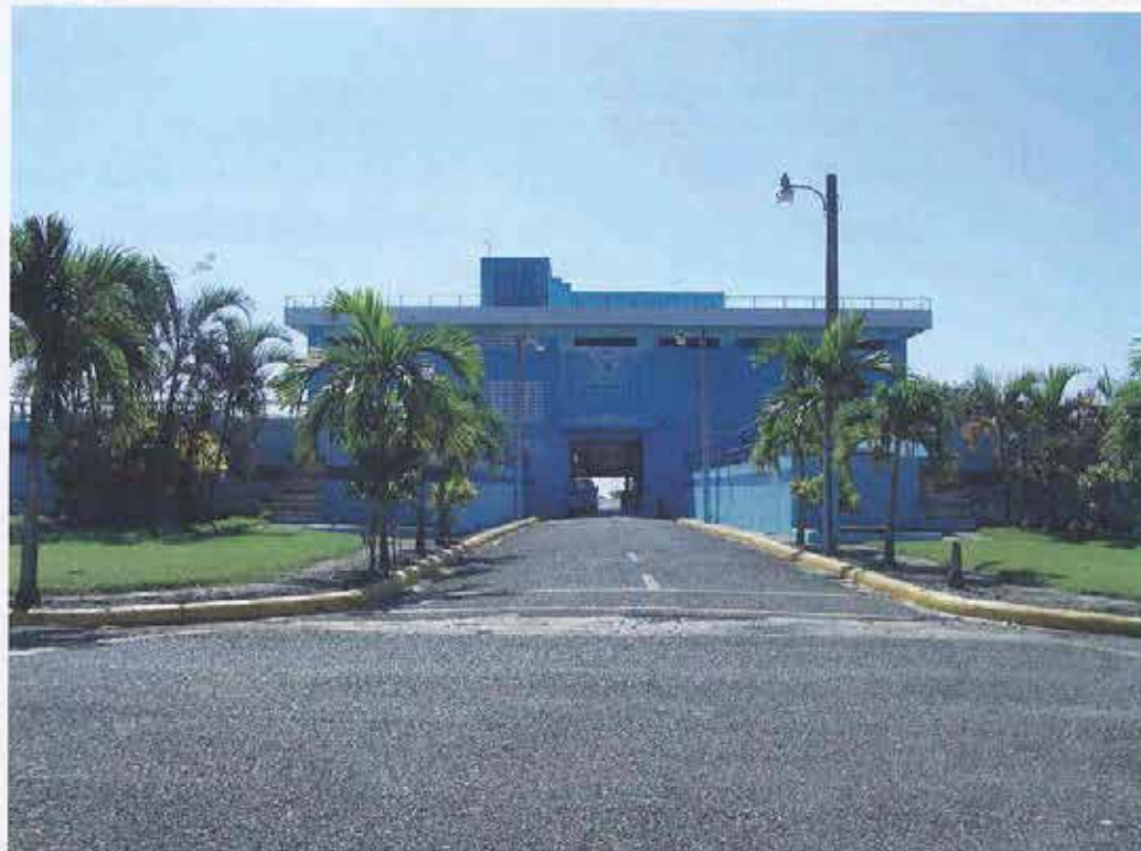
Planta de Tratamiento
