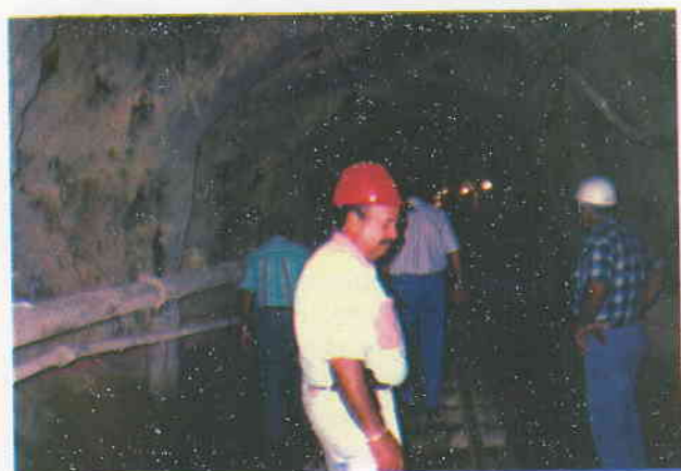
El Sr. Pantaleón Salcedo, supervisando los trabajos de la construcción del acueducto Cibao Central
