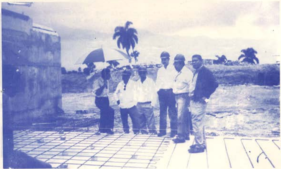
Ciclo de observación a las instalaciones del Acueducto Cibao Control, Pinar del Río, a lo cual asisten Los Ingenieros Ricardo Canalda, Director de la Corporación de Acueductos y Alcantarillados de Santo Domingo (CAASD), Rafael Santos, Mateo Espallat, Nelson Sánchez y Pantaleón Salcedo en labores de inspección de la planta de tratamiento ubicada en Tierra Dura, Moca.
